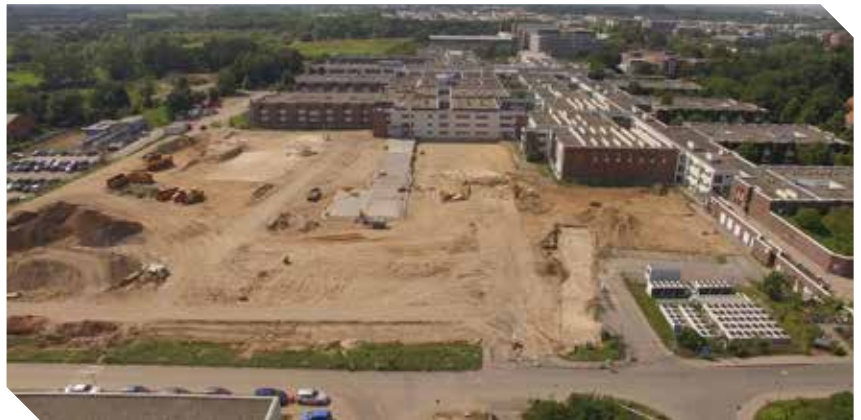
Auf dem ehemaligen Parkplatz am Zentralklinikum entsteht die Baugrube für den Neubau.
