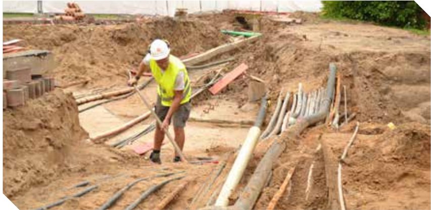
Beginn der Ausgrabung der alten Leitungen und Rohre
