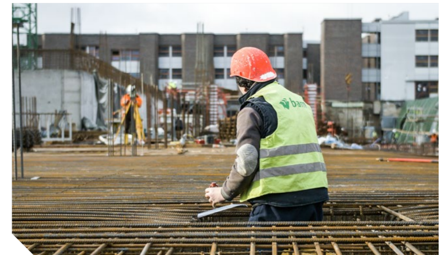
6.600 Tonnen Stahl in Form von solchen Stahlgittern bilden die Grundlage für den Rohbau.
